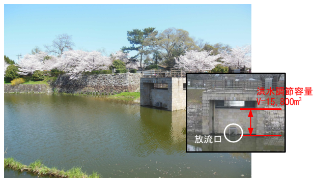
図 7-3 ため池の治水利用 (鰻堀池・大和郡山市)
