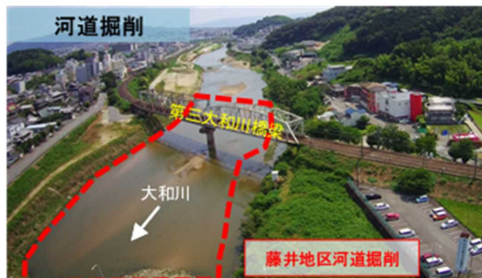
図 4-3 藤井地区河道掘削
