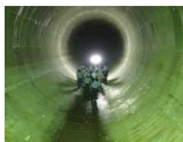
雨水貯留管の整備
