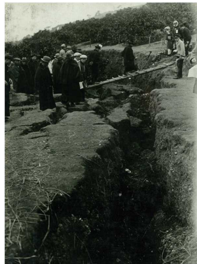
写真 1-1 昭和 6 年 亀の瀬地すべり被害状況
