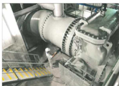
雨水ポンプの整備
