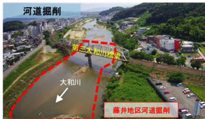
図 4-3 藤井地区河道掘削
