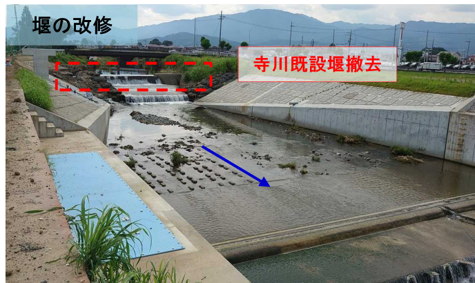
図 4-5 桜井市大福工区佛生井堰（寺川）
