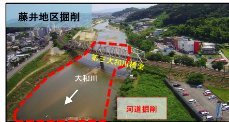
図 2-3 藤井地区掘削
