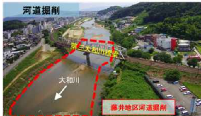
図 4-3 藤井地区河道掘削
