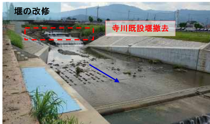
図 4-5 桜井市大福工区佛生井堰（寺川）
