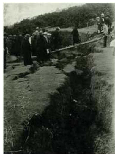
写真 1-1 昭和 6 年 亀の瀬地すべり被害状況
