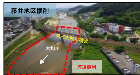
図 2-3 藤井地区掘削
