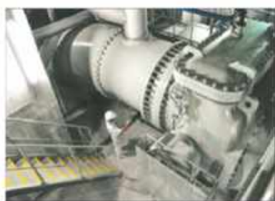
雨水ポンプの整備
