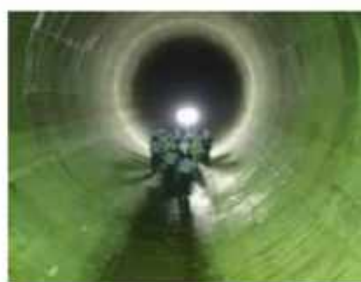
雨水貯留管の整備
