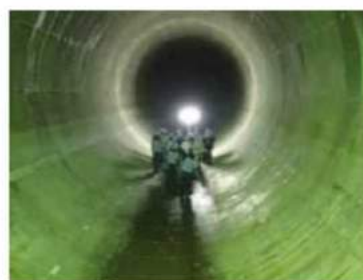
雨水貯留管の整備
