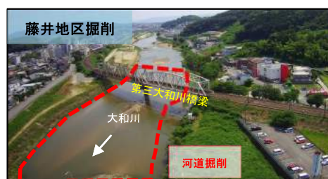
図 2-3 藤井地区掘削
