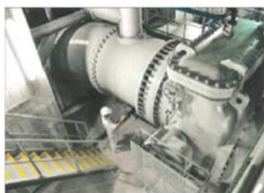
雨水ポンプの整備
