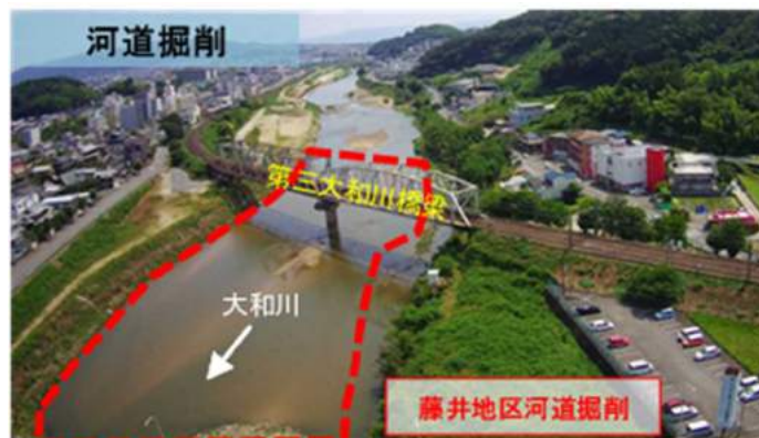
図 4-3 藤井地区河道掘削
