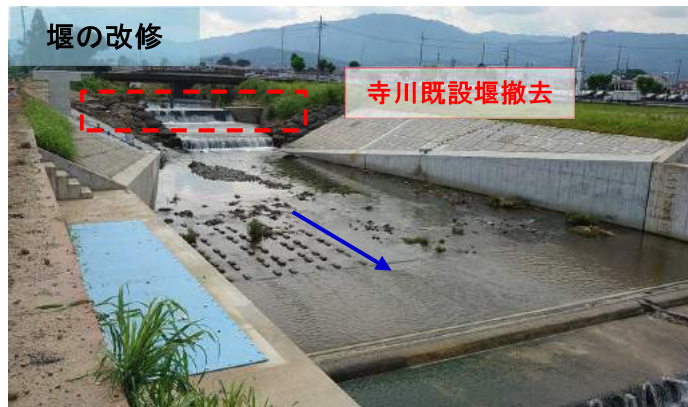
図 4-5 桜井市大福工区佛生井堰（寺川）
