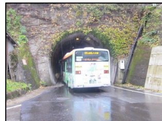
すれ違いが困難なトンネル
