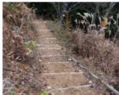
以前の階段の状況
