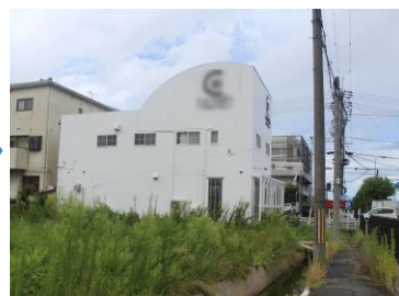
撤去後（H30.8撮影）
