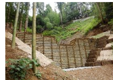
谷止工(公共事業への間伐材利用)
