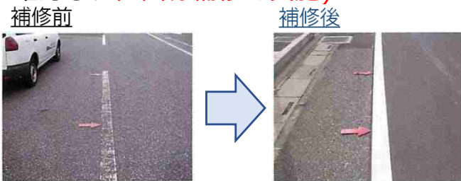
▲消えかけた区画線の修繕 出典：路面表示と交通安全 (全国道路標識・標示業東京都協会)
