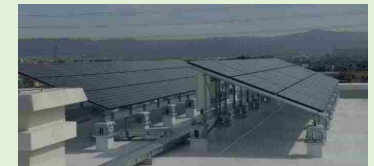
県有施設への太陽光パネル設置
