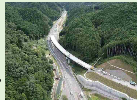
暫定2車線バイパス工事を推進 (高取町清水谷) 【 令和7年度 完成供用 】
