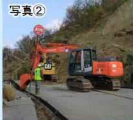
国道249号緊急復旧作業状況
