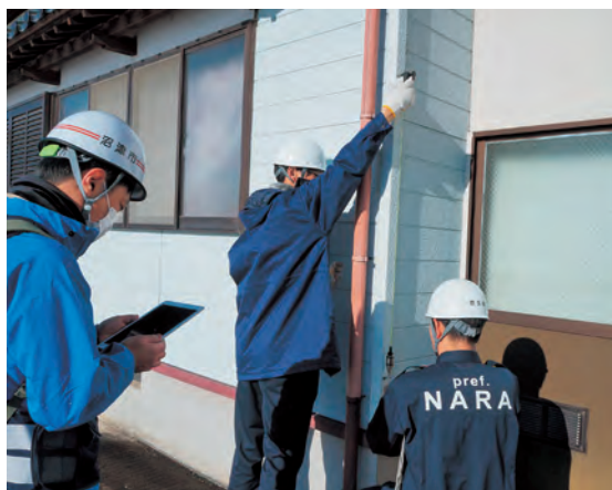
奈良県職員による建物被害認定調査の様子
