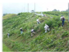
法面の共同草刈り作業
