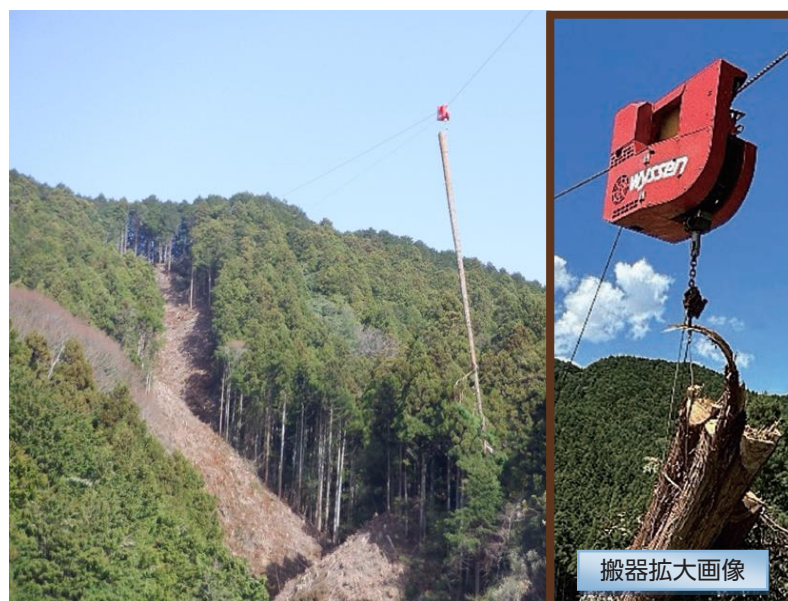
高取山国有林の皆伐現場(実証試験) (詳しくは4～5ページ)
