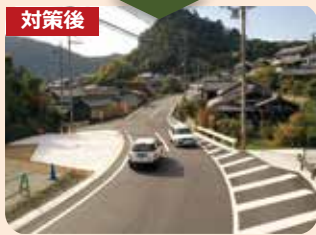
▲ アクセス道路の整備 (一般県道入野河原屋線 河原屋工区)
