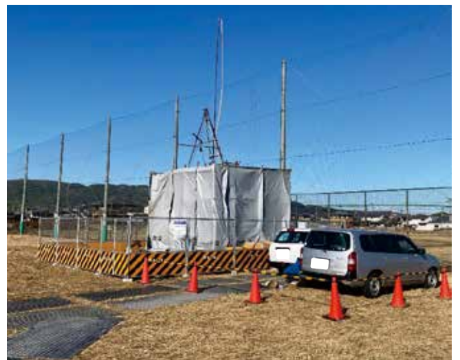
▲地質調査の様子（大和郡山市）
