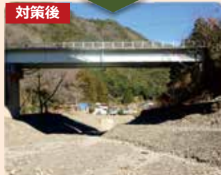
▲ 橋梁の補修工事 (国道168号河津橋)
