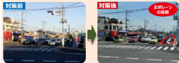
▲ 渋滞緩和に向けたハード対策 (国道24号 葛本町交差点〔R4.3完了〕)
