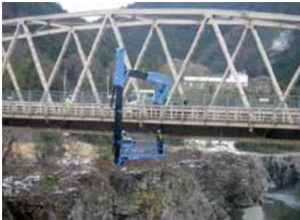
▲橋梁の定期点検
