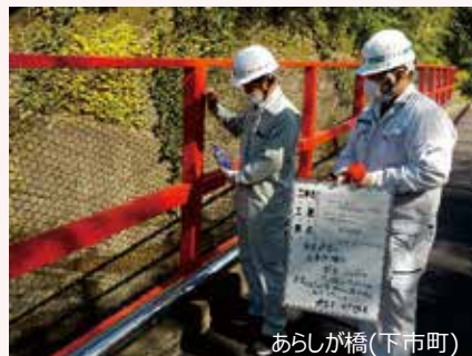
▲県が修繕工事を受託した橋梁の検査を県職員と市町村職員が一緒に実施
