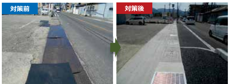
▲歩道設置（国道166号 葛城市尺土）
