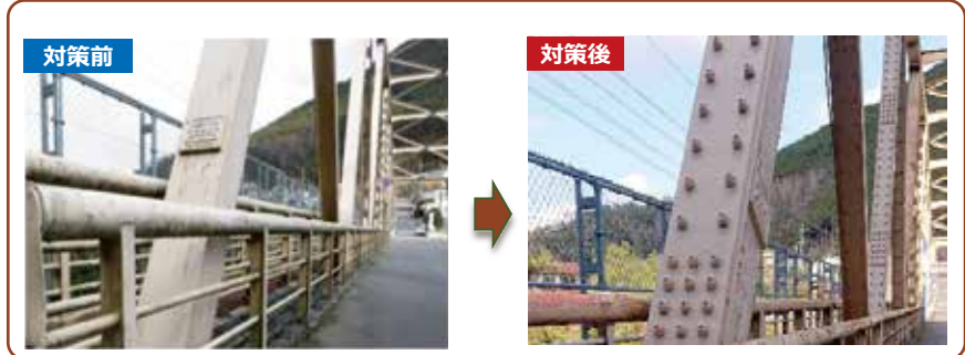
▲当て板補強による補修工事
