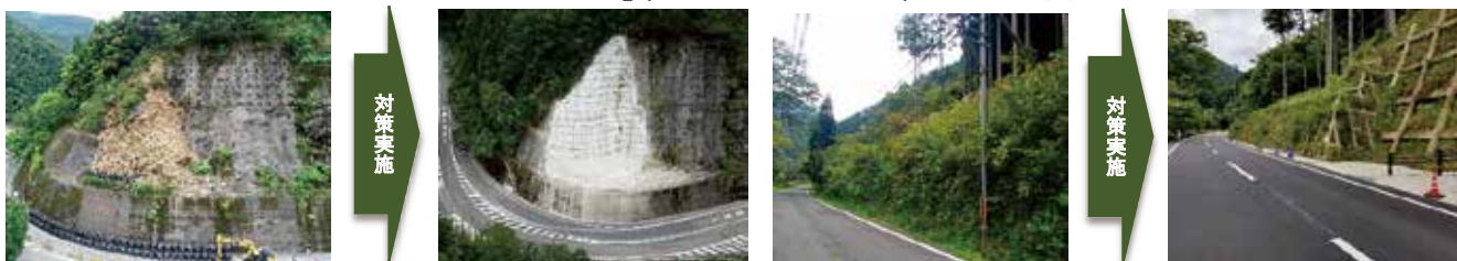
▲法面対策（国道168号 十津川村野尻）
