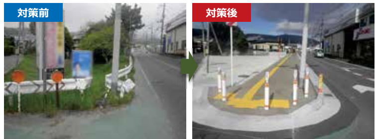
▲歩道設置（国道168号 生駒郡平群町吉新）
