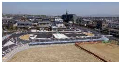
◀近鉄結崎駅周辺地区(川西市)駅前ロータリーの整備
