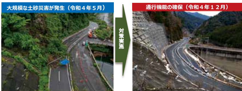
▲法面対策による通行機能の確保（国道169号 川上村大迫）
