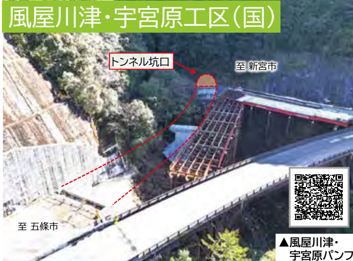
十津川村川津 橋梁下部工事
