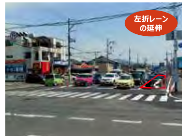
▲ 渋滞緩和に向けたハード対策 (国道24号 葛本町交差点)
