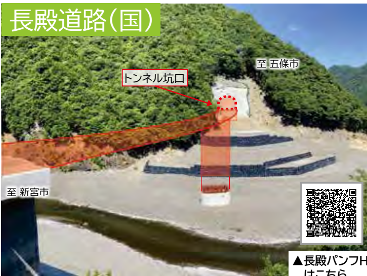
十津川村長殿 橋梁下部工事
