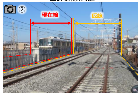
▲南大安寺踏切付近(仮線工事)
