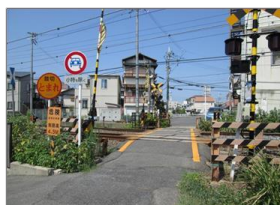
▲南大安寺踏切道
