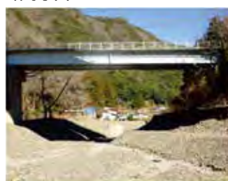
▲ 橋梁の補修工事
