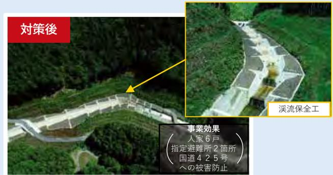
▲渓流保全工を施工し、土砂流出再発を防止。
