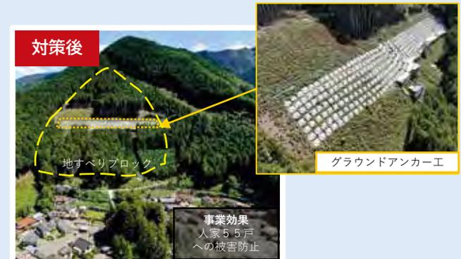
▲グラウンドアンカー工を施工し、地すべり再発を防止。
