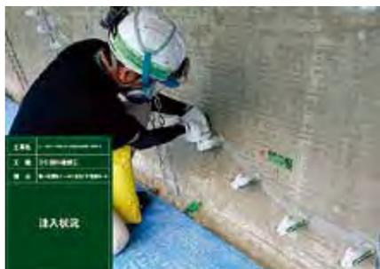
▲橋梁補修工事(ひび割れ注入工)
