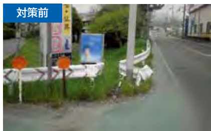
▲通学通園路の合同点検で対策が必要となった箇所 (国道168号 生駒郡平群町吉新)
