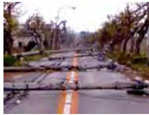
▲台風で倒壊した電柱が道路を塞いでいる (出典:国土交通省ウェブサイト)
