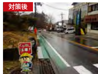
▲路側帯のカラー舗装化(国道309号 大淀町下淵)
