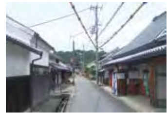
▲歴史ある街並みを電柱・電線が阻害 (県道から甘樫丘を望む)
