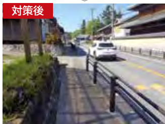
▲国道369号 奈良市都祁吐山町
