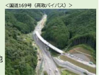
<国道169号(高取バイパス)> 暫定2車線バイパス工事を推進(高取町清水谷) 【令和7年度完成供用】
