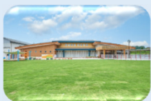
保育施設の整備
