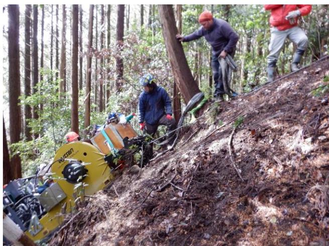
器具の取扱いのレクチャーを受けながら、測量・現地踏査に2日、架設に6日間を要して、支間傾斜角14度、支間水平距離560mの架線を設置した。
