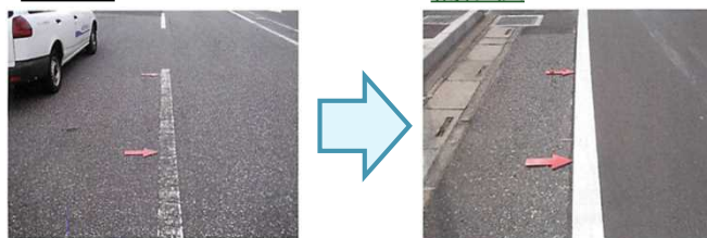
▲消えかけた区画線の修繕 出典：路面表示と交通安全（全国道路標識・標示業東京都協会）
