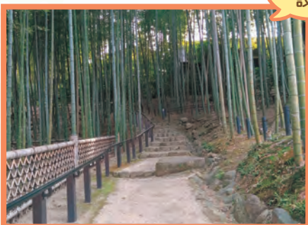
手すりの設置
