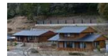
【十津川村復興住宅】
