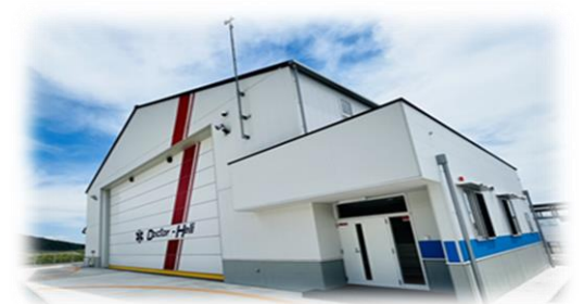
格納庫・給油施設
