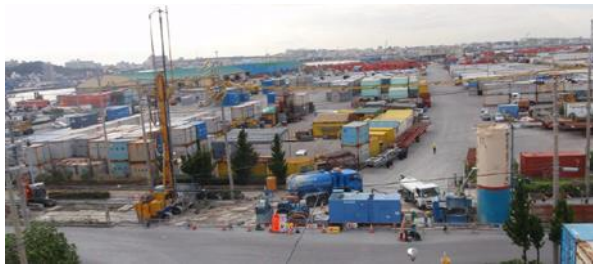
【出典】供用中の臨港道路直下での2流線式固化材スラリー噴射攪拌工法の施工事例 (第28回沖縄地盤工学研究発表会論文)
