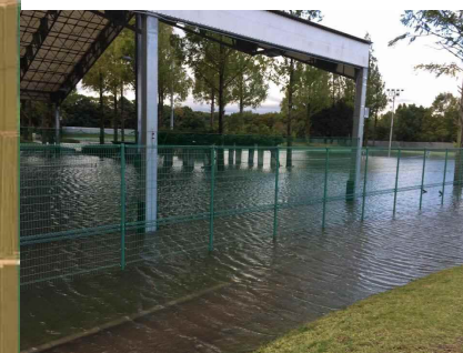
○ 浸水状況 (H29.10台風21号)
