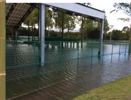
○ 浸水状況 (H29.10台風21号)
