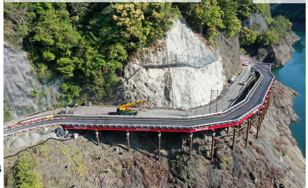
写真④ 応急対策工事 (仮橋完成)
