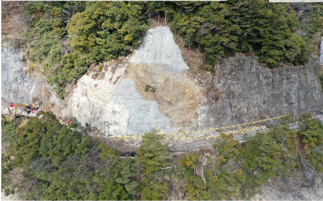
写真③ 応急対策工事 (高エネルギー吸収柵工完、仮橋着手)
