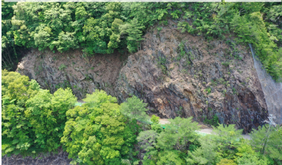
全景（落石防止ネット撤去） R6.6.14
