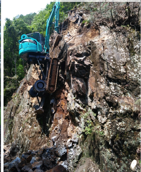
不安定岩塊の掘削状況 R6.6.19
