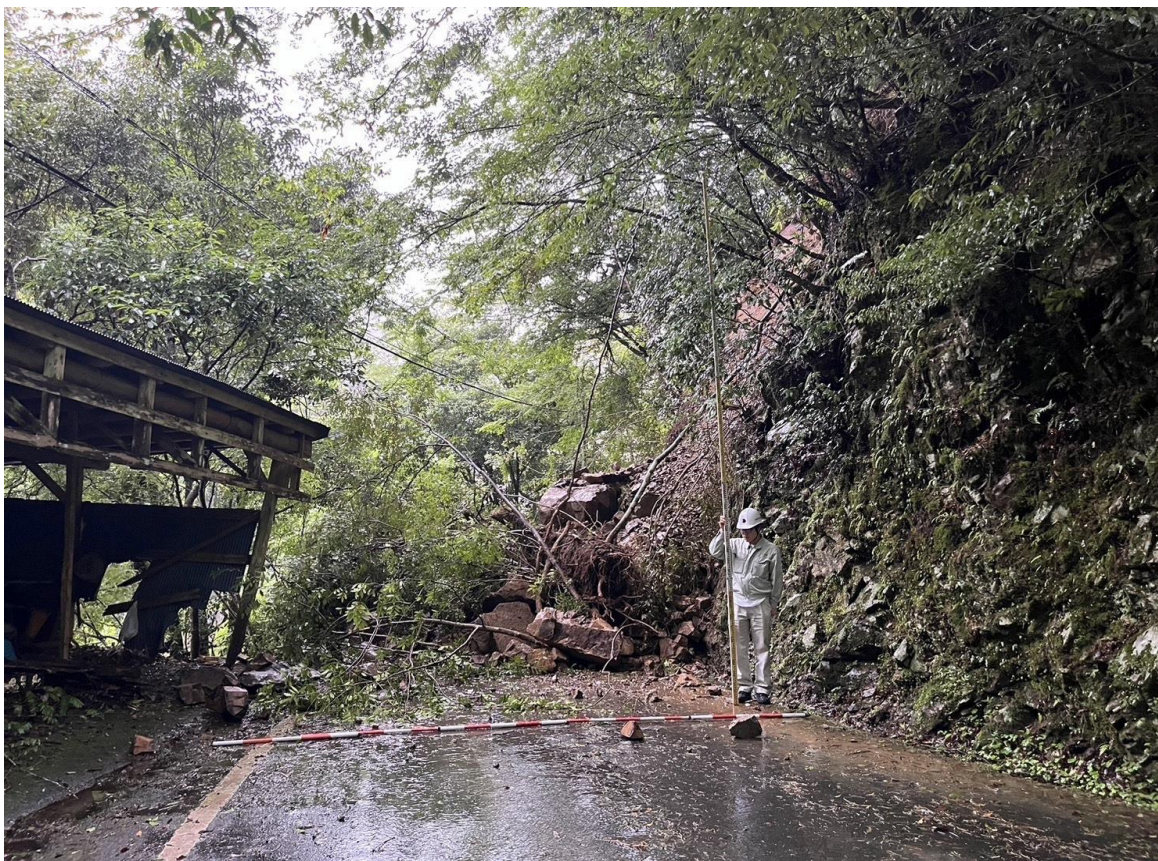
7/1 崩土現場写真 (国道425号十津川村西中)
