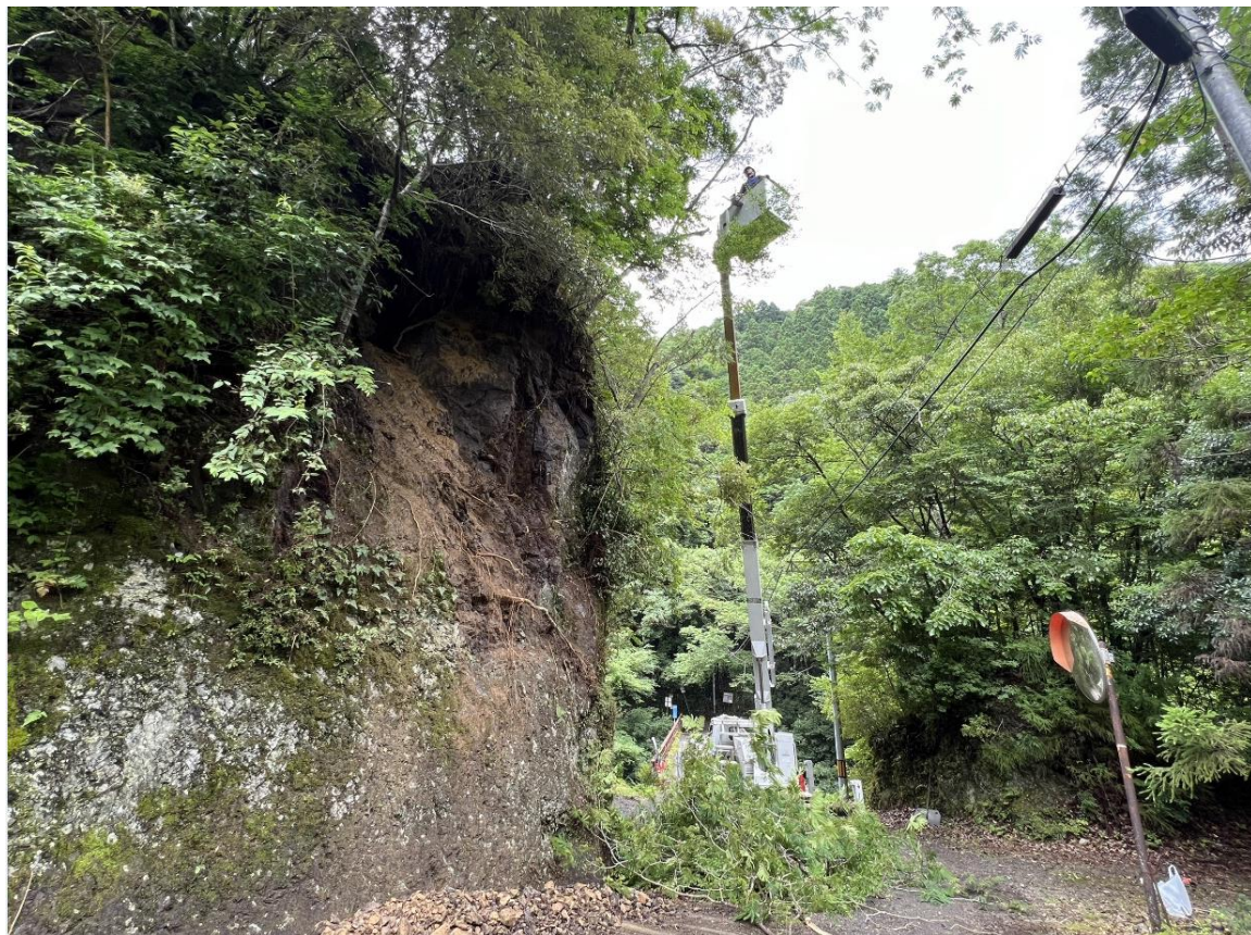
6/29 崩土現場写真 (国道425号十津川村小坪瀬) (7月2日撮影)
