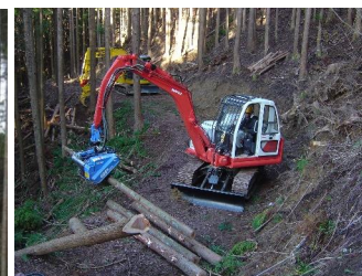
高性能林業機械による造材
