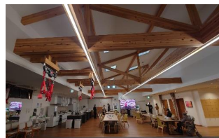
県産材を使用した公共建築物 (ぼれぼれケアセンター青山 令和5年5月オープン)
