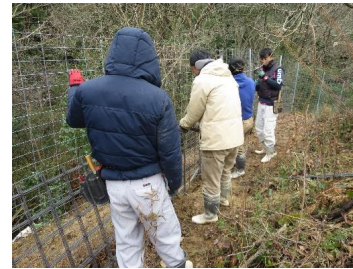
共同作業による防護柵(ワイヤーメッシュ柵)の設置
