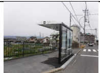
白毫寺バス停上屋整備
