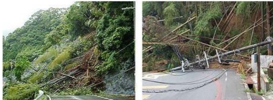
倒木や土砂等により電線が切れ漏電し地絡 ⇒ 当該の回線が停電する。
