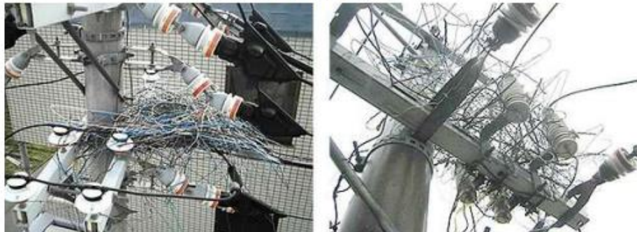
カラスの巣が高圧線に接触し漏電し地絡 ⇒ 当該の回線が停電する。
