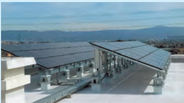
県有施設への太陽光パネルの設置
