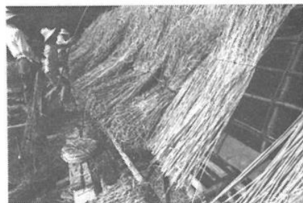
◀軒付け部を仕立中(屋根下地の上に化粧茅を一通り並べ、この上にダン茅で、一定の厚みに積む)
