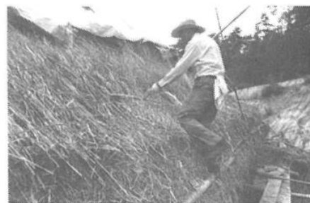
◀竹製のハリで押え竹と屋根下地材を結ぶところ(この上に捨て茅をのせる)
