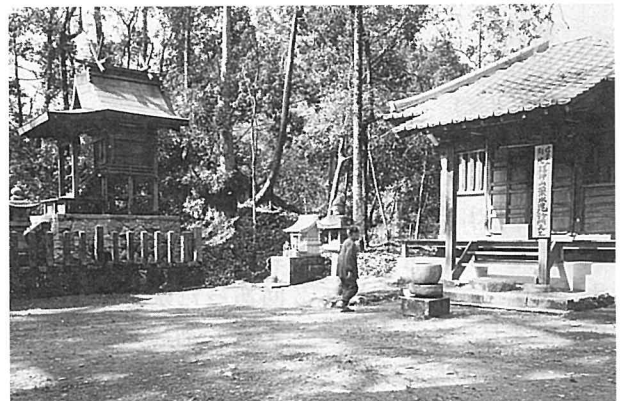
▲八幡神社本殿（左）と毘沙門堂（大淀町薬水）
