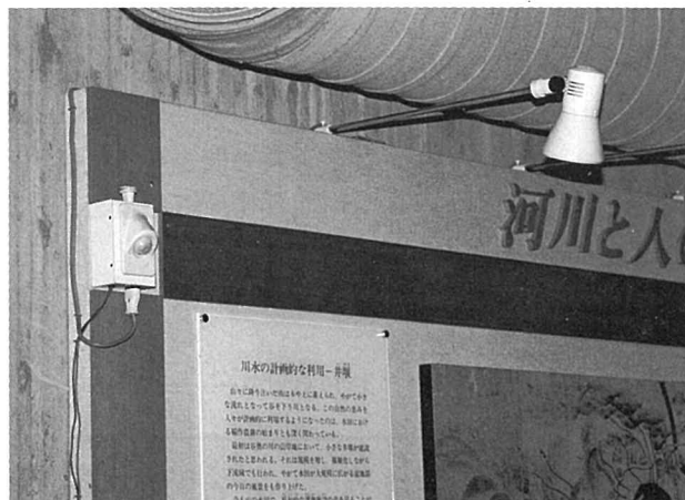
2. コーナー設置例 (60w×5個の白熱球に制御電流を供給)
