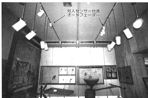
3. 天井への設置例（左右に各1個それぞれ100W×6個を制御）
