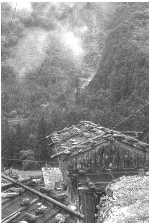
石置き屋根にスバル板の民家はこの地域の特色。今これらの屋根はトタン葺きに変わっている。
