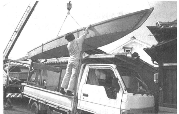
▲堀越しの積み込み作業（h.12/12/12）
