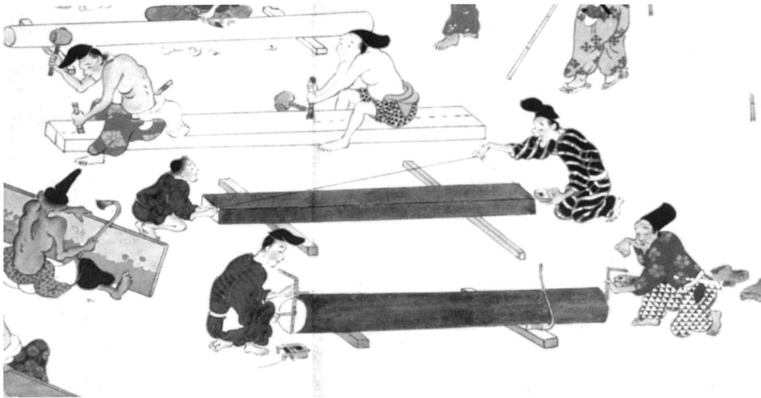
天曆二年二月に藤原光弘が大和国平群郡夜摩郷に春日大明神を祀る竹林殿造営の光景。サシガネとスミサシ・スミツボで心出し（下）、墨糸を張り墨を打つ（中）光景等がリアルに描かれている。原本の成立は延慶二年（二〇九）、当時の建築工事の様子を知る資料として貴重なもの。 図1 春日権現験記絵 第一巻（春日大社蔵、江戸後期模本）
