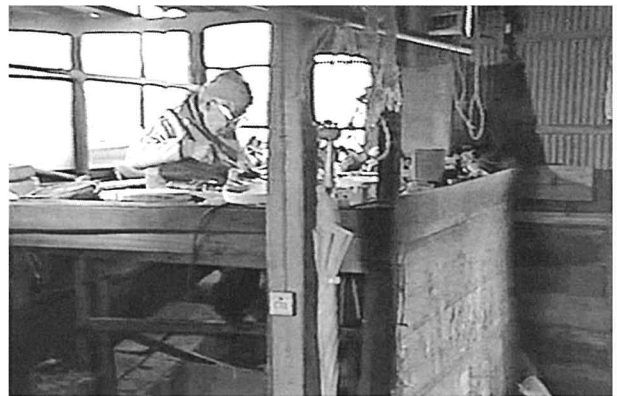
カンナマエの作業の様子
