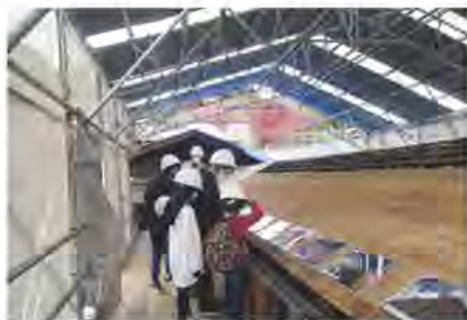
旧前坊家修理現場見学会
