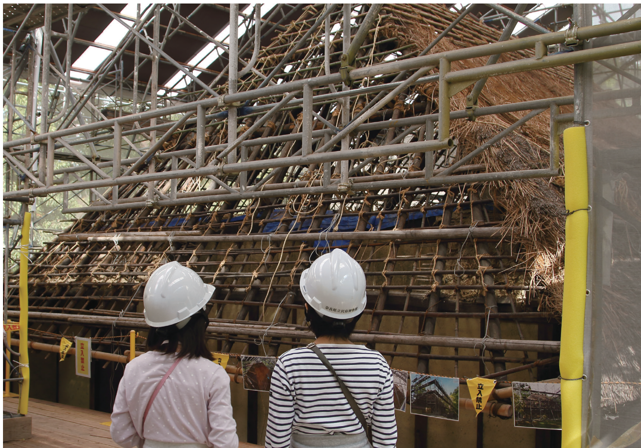
旧八重川家住宅の葺き替え工事（修理現場公開における見学の様子）
