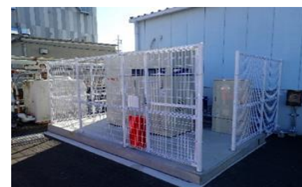
化学工場へのガスコージェネレーションシステムの導入
