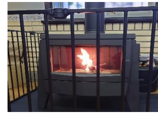
薪ストーブの設置（下市町内）
