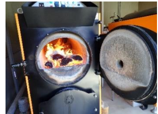
薪ボイラーの設置（天川村内）
