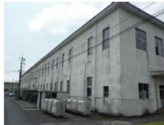
【現状施設の例(庁舎)】
