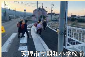
天理市立朝和小学校前 歩行者の安全を確保した道路
