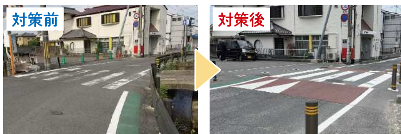
▲ ゾーン30プラスによるスムーズ横断歩道の整備(県道谷田奈良線(奈良市))
