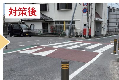
▲ ゾーン30プラスによるスムーズ横断歩道の整備(県道谷田奈良線(奈良市))
